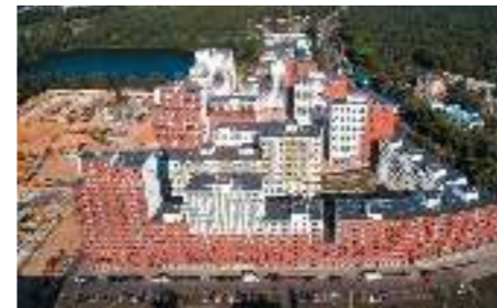
ЖК «Новокрасово», МО «Тройка РЭД»
